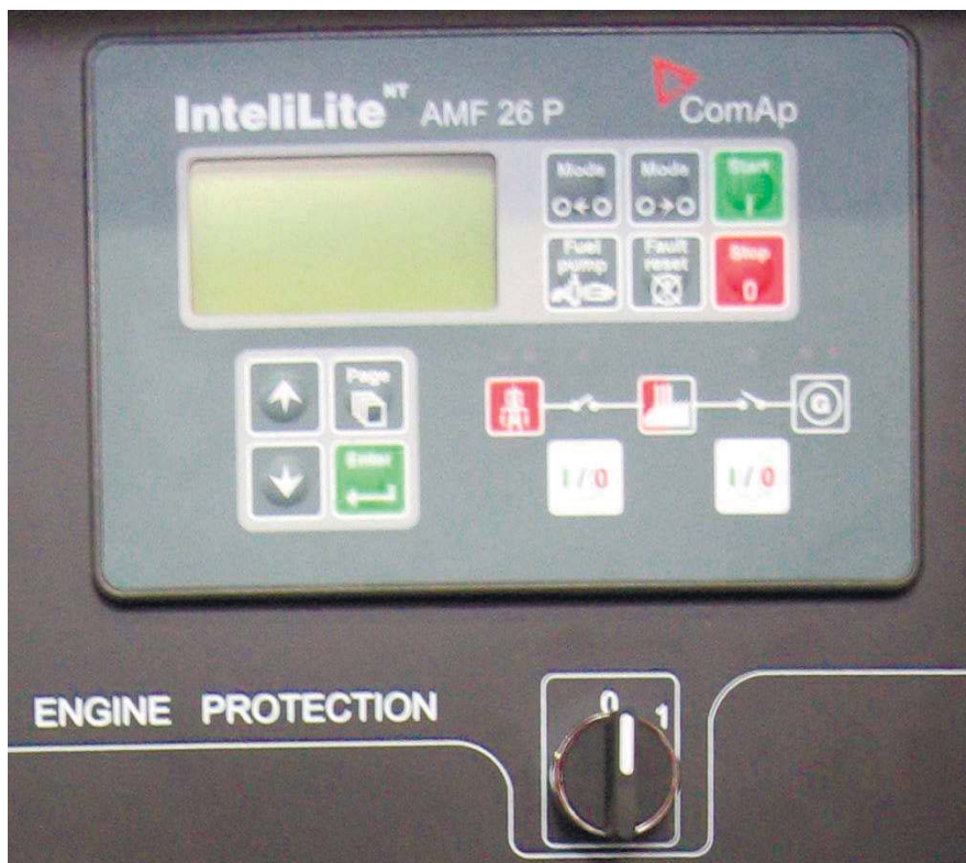
Рис. 14 - Кнопка отсоединения панели от питания и панель автоматического запуска контроля мотора
